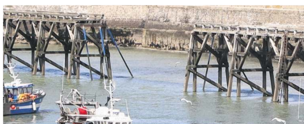
Dans un an environ, les promeneurs pourront de nouveau circuler sur l'estacade Est.
